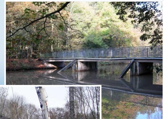
Situation vor dem Ersatzneubau
