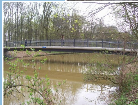
Situation nach dem Ersatzneubau
